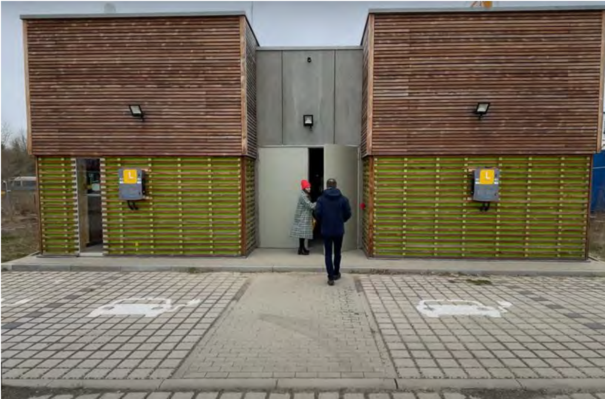
Bild: Heizhaus in Schkeuditz
